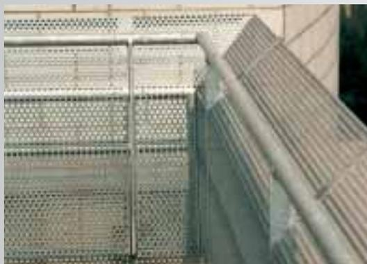
**Après:** pour assainir la balustrade, une tôle perforée a été montée sur sa partie intérieure, ce qui la rend plus difficile à escalader. L'inclinaison vers l'extérieur empêche de s'asseoir sur le rebord.
