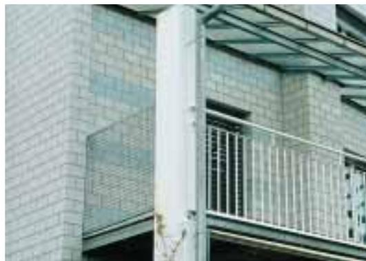
Combinaison: finition frontale constituée de barreaux et d'un grillage métallique latéral; le tout forme une balustrade transparente et sûre.
