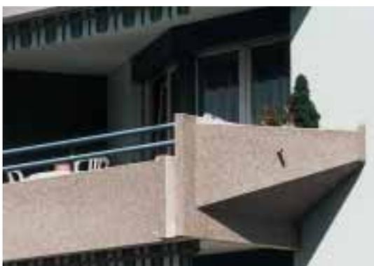
Balustrade de balcon: éléments de béton jusqu'à une hauteur de 65 cm, hauteur totale du parapet 1.0 m, jusqu'à 75 cm, pas d'ouverture supérieure à 12 cm de  $\varnothing$ , bord supérieur vers les bacs à fleurs latéraux à 1.0 m.
