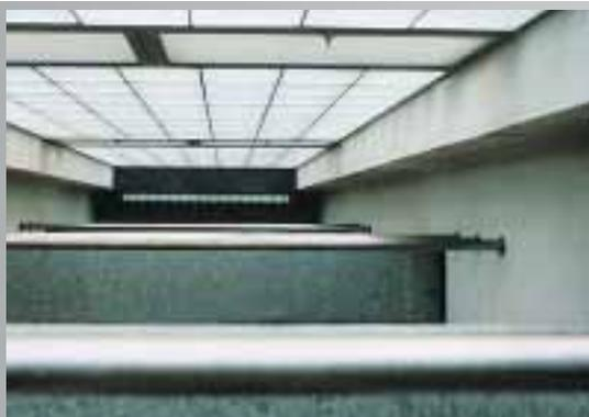
**Avant:** l'espace entre le palier d'escalier et les briques de verre est relativement large. Les trois traverses horizontales disposées sur toute la largeur de la cage d'escalier n'offrent pas de protection suffisante contre les chutes.
