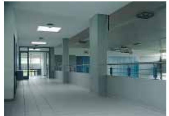
Parapet d'une galerie: hauteur totale 1.1 m, parapet de béton 65 cm au moins, pas d'ouverture supérieure à 12 cm de  $\varnothing$  jusqu'à une hauteur de 75 cm.
