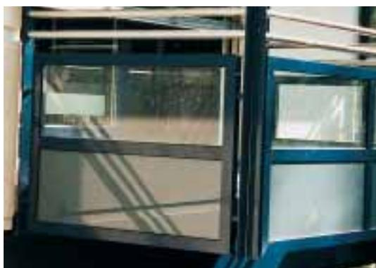
Balustrades de balcon en verre de sécurité feuilleté: deux traverses horizontales chromées avec un parapet en verre en bas forment une protection contre les chutes fermée, transparente et difficile à escalader.
