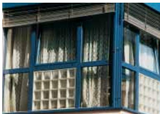
Finition d'une paroi vitrée: briques de verre au milieu et verre de sécurité feuilleté (VF) tout autour, traverse horizontale à 1.0 m.
