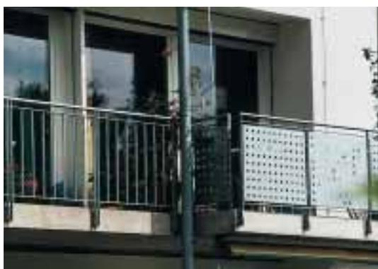
Mise en relief des différents balcons par divers types de balustrades: tôle perforée et barreaux de protection contre les chutes, main courante à 1.0 m comme finition supérieure.
