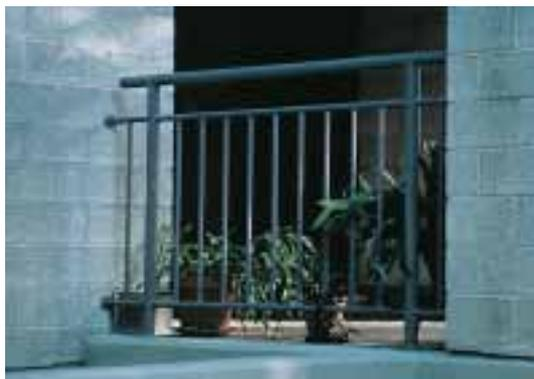
Variante transparente: barreaux verticaux et main courante surélevée sur une hauteur de 1.0 m, pas d'ouvertures supérieures à 12 cm de  $\varnothing$ .
