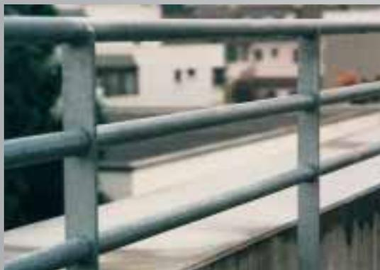
**Avant:** la balustrade de béton de 45 cm de haut et les traverses métalliques horizontales peuvent facilement être escaladées. La bordure supérieure est idéale pour s'asseoir.
