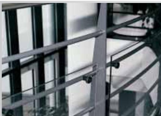
**Après:** la transparence et la légèreté de la balustrade ont pu être maintenues grâce au montage, sur une hauteur de 65 cm et à l'intérieur, d'un verre de sécurité. La balustrade est plus difficile à escalader.
