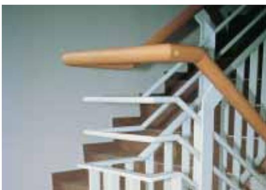
Rampe d'escalier intérieur: barreaux verticaux difficiles à escalader jusqu'à 65 cm, pas d'ouverture supérieure à 12 cm de  $\varnothing$ , hauteur totale 1.0 m, combinaison de matériaux: bois pour la main courante et métal pour la protection contre les chutes.
