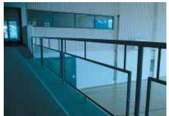
Espaces réservés au public: protections contre les chutes transparentes, vue dégagée sur les surfaces de jeux, pas d'ouverture supérieure à 12 cm de  $\varnothing$  jusqu'à une hauteur de 75 cm.
