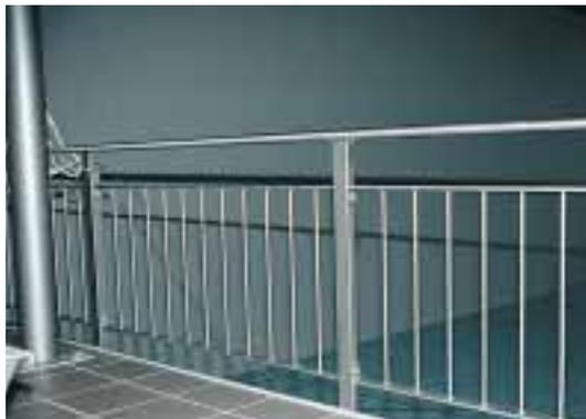
Balustrade composée de barreaux verticaux: hauteur minimale 1.1 m, difficile à escalader, transparence garantie.
