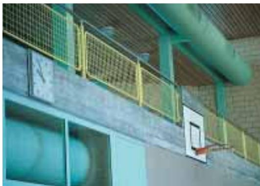
Protection contre les chutes: grillage métallique ou treillis métallique en diagonale, largeur de maille 4 cm au maximum, hauteur 1.1 m au moins.
