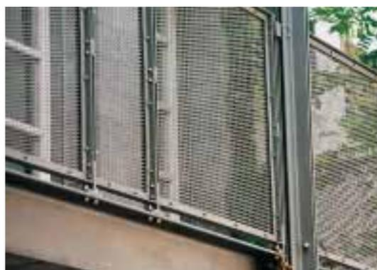
Balustrade de balcon en tôle déployée encadrée et fixée sur une construction primaire, pas d'ouvertures supérieures à 12 cm de  $\varnothing$ .
